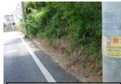
側溝蓋上の土・草の除去
