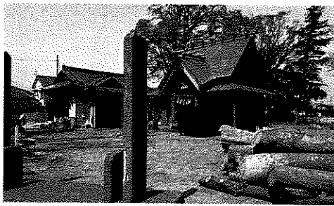
神明神社が移転して更 地になり、拡張工事が開 始（同一箇所の写真） 左 写真1 移転前 右 写真2 工事開始
